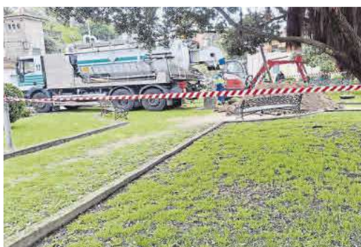
Zona acordonada por culpa de las obras.
