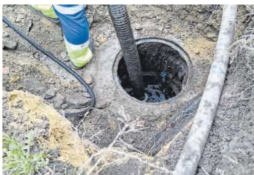
Colector que se pretende renovar.
