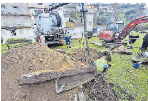
La alameda de Aldán, levantada por culpa de las obras.
