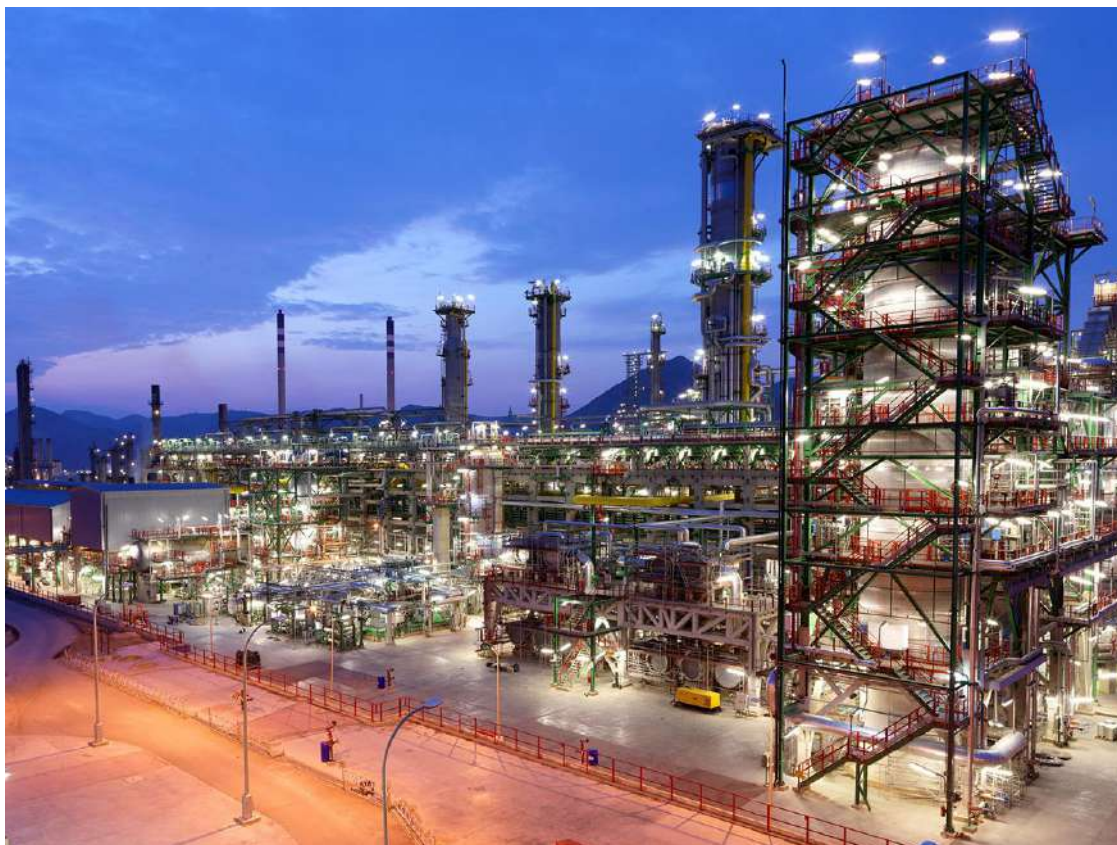
Instalación de Técnicas Reunidas. FOTO: Técnicas Reunidas
